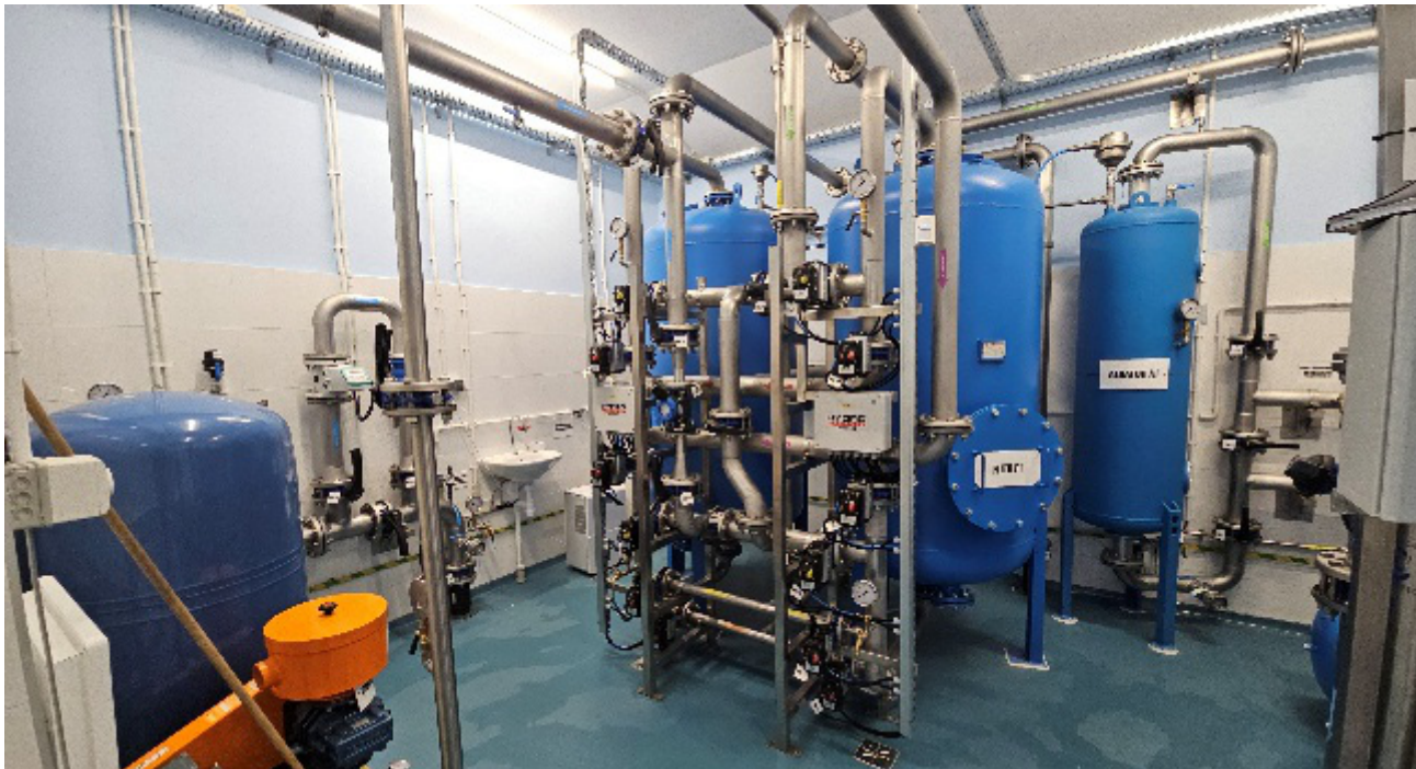
Przebudowa stacji uzdatniania wody w Saminie, gm. Dąbrówno
