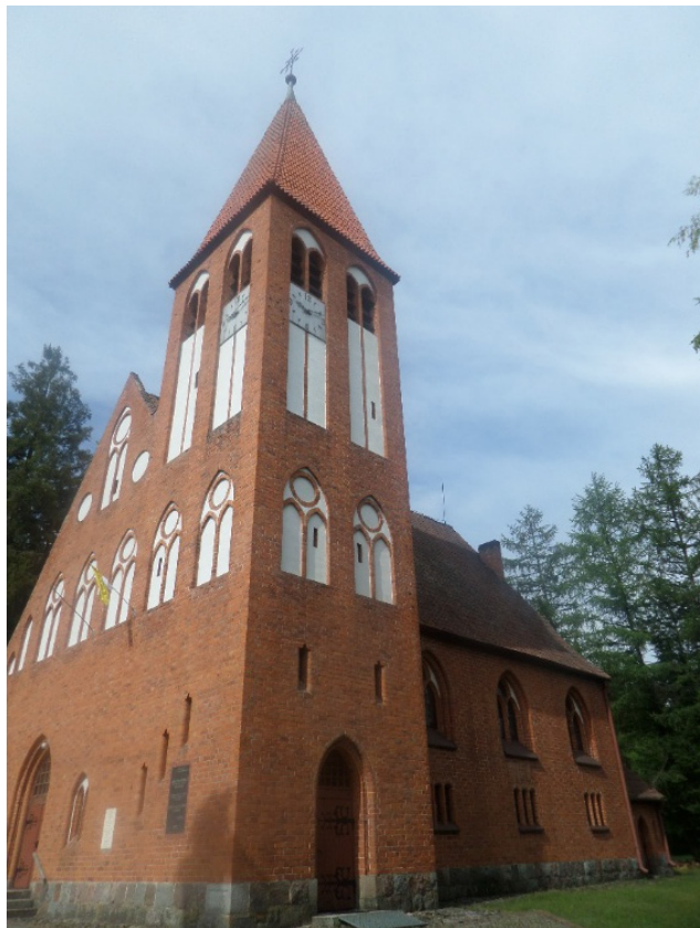
Remont dachu wieży kościoła Najświętszej Maryi Panny Nieustającej Pomocy w Spychowie, gm. Świętajno w powiecie szczycieńskim
