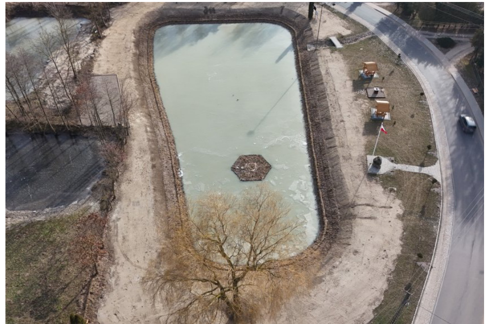
Przebudowa zbiornika wodnego o charakterze retencyjnym w miejscowości Dębnie, gm. Rybno
