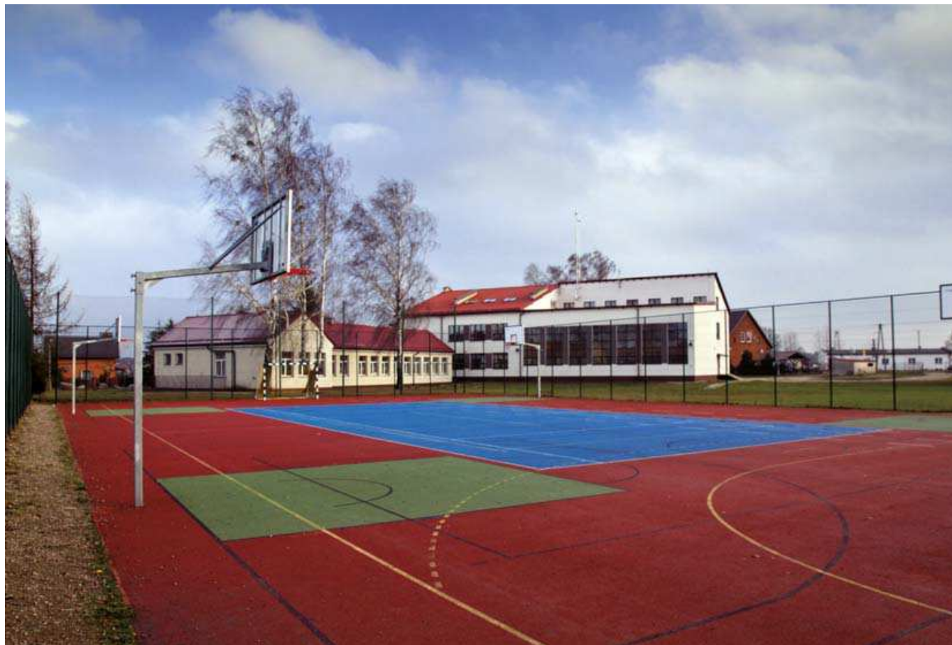
Budowa boiska wielofunkcyjnego ze skocznią w dal i bieżnią w Jamielniku
