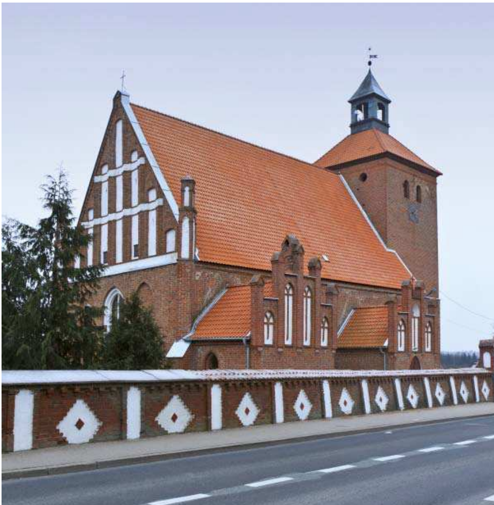
Remont dachu zabytkowego kościoła p.w. Św. Barbary w Rogóże
