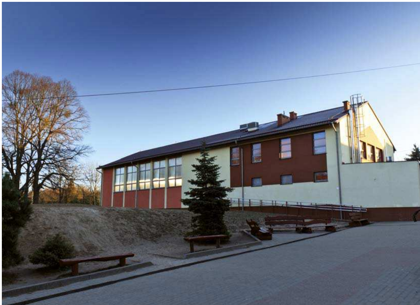
Budowa sali gimnastycznej w Czerwonce
