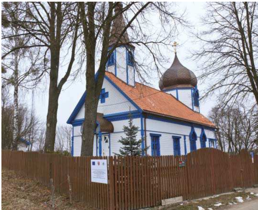
Remont zabytkowej cerkwi p.w. Zaśnięcia Najświętszej Marii Panny we wsi Wojnowo wraz z otoczeniem
