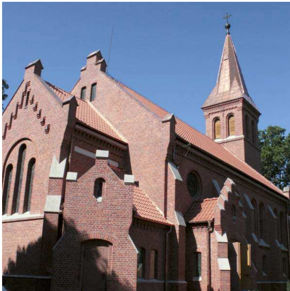
Remont dachu i elewacji w kościele p.w. Św. Piotra i Pawła w Użrankach
