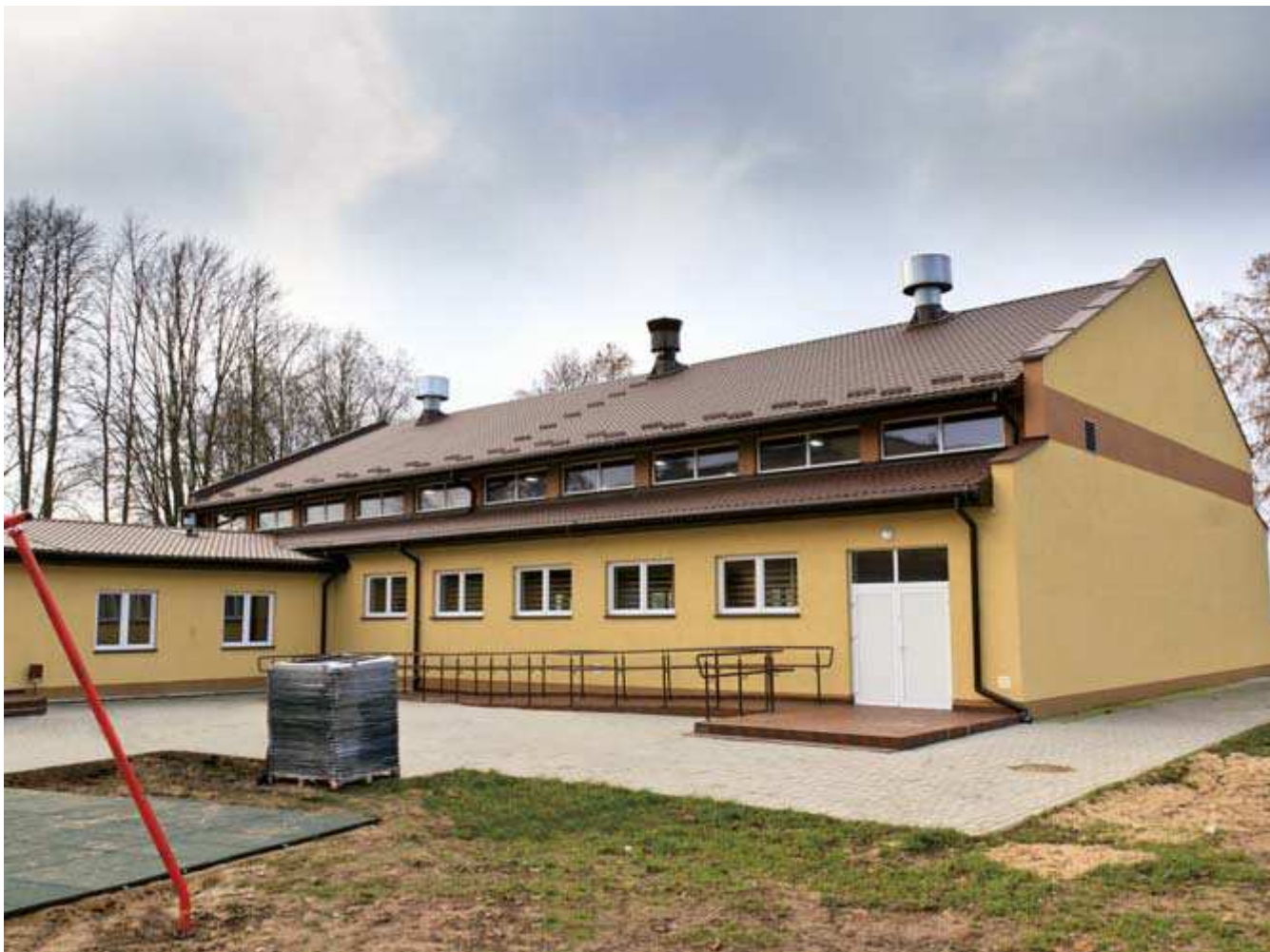
Budowa sali sportowej w miejscowości Niechłonin
